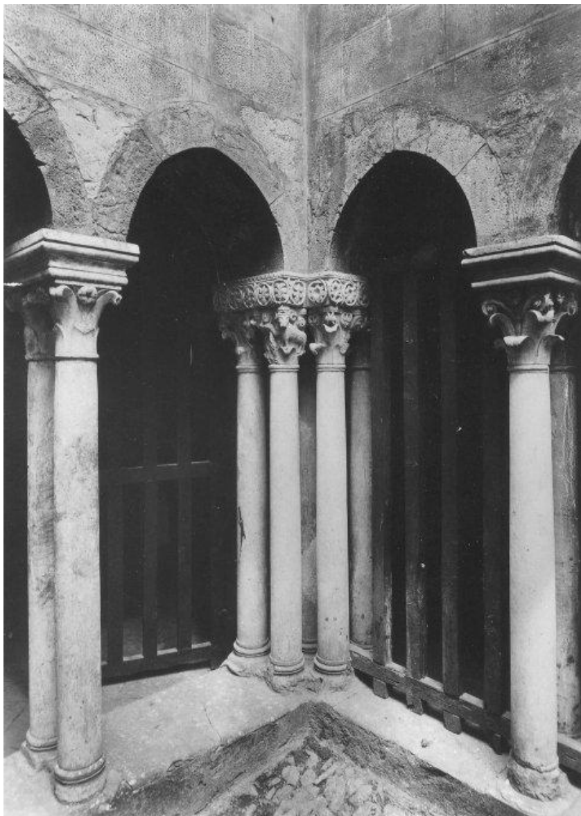
Figura 3 - Chiostro del monastero di Sant'Andrea della Porta (Genova), 1904 prima dello spostamento
