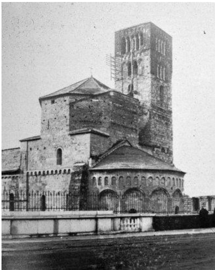
Figura 2 - Monastero di Santo Stefano (Genova), zona absidale
