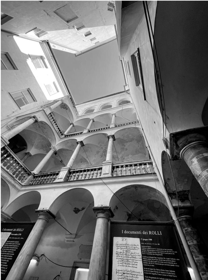
Fig. 16 - Palazzetto criminale, cortile loggiato. Sono visibili i tre ordini di logge risalenti al XVI secolo e l'ultimo piano porticato risalente alla sopraelevazione del 1879. (fotografia di Lucina Napoleone 2021).
