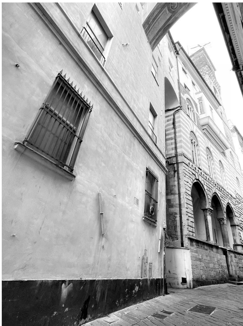
Fig. 8 - Genova, via Tommaso Reggio all'angolo con salita dell'Arcivescovato. In questa ripresa è ben visibile in primo piano il Palazzetto e oltre la salita dell'Arcivescovato la sottomurazione della Loggia di Palazzo Ducale che, a seguito dei lavori di abbassamento delle quote di via Tommaso Reggio si trova a quasi due metri dal suolo. (fotografia di Lucina Napoleone 2024).
