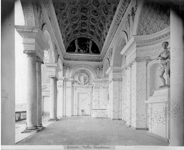
Fig. 9 - Alfred Noack, villa Giustiniani Cambiaso, Genova. Veduta della loggia nord, 1860-1880, (Genova, Centro di Documentazione per la Storia, L'Arte e l'Immagine di Genova, Archivio Fotografico).
