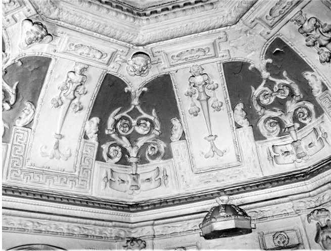
Fig. 27 - Villa Pallavicino delle Peschiere, Genova. Bagno, dettaglio.
